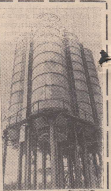
Строительство комбикормового завода.
